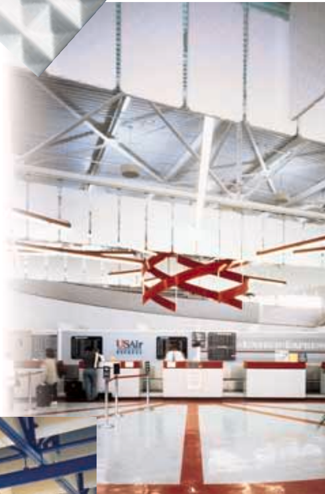
Baffel-Absorber zur Lärminderung im Flughafen Tweed New Haven, CT; Fa. illbruck/USA
