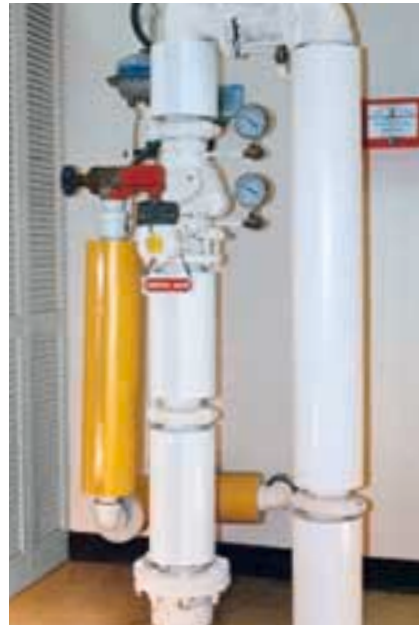
Isolierung von Industrieanlagen Fa. Accessible Products/USA
