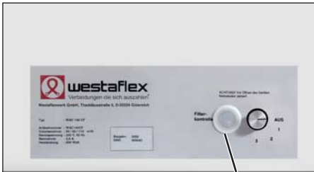
Signallampe für Filterkontrolle
